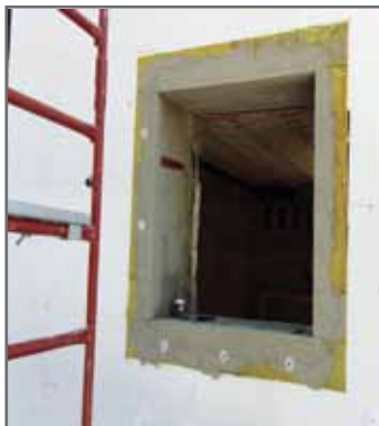
Balra: Homlokzati hőszigetelőrendszer tűzterjedési tesztelése
