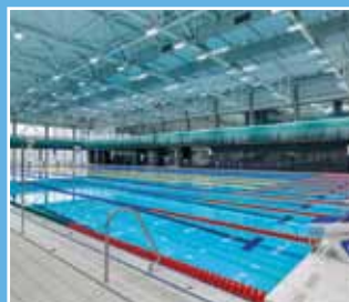
Duna Aréna nagymedence kivitelezése
