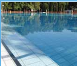
Harkányi Lepke medence felújítása
