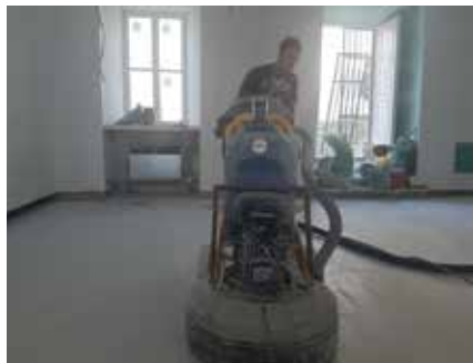
Venecei műkö jellegű padlófelület kialakítása az ULTRATOP rendszer gyémánttárcsás szárazcsiszolásával.
