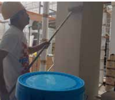
A végső SILEXCOLOR védőréteg felhordása.
