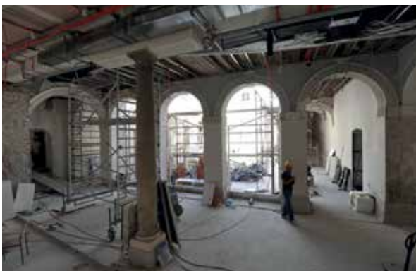
Az érseki palota a rekonstrukció idején.
