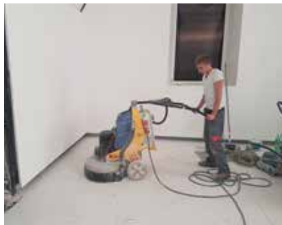
Az ULTRATOP réteg durvacsiszolása a felhordás után három nappal.
