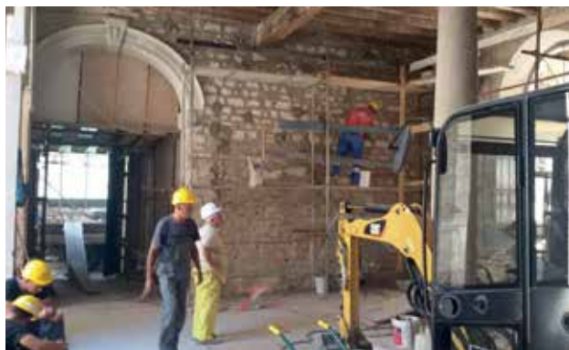
A felületek előkészítése a POROMAP INTONACO MACCHINA vakolat felhordása előtt.
