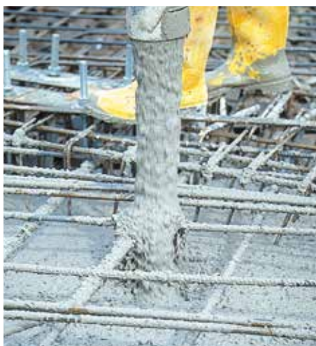
Getto in opera di una soletta in calcestruzzo
