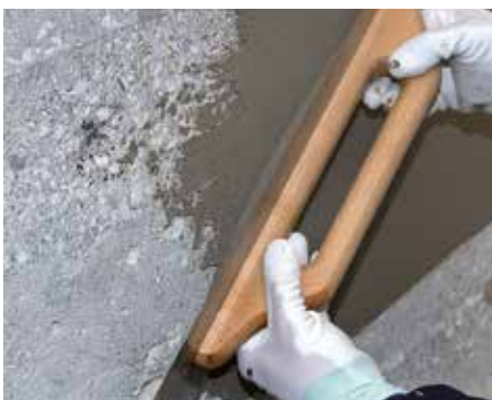
Applicazione di rasatura tissotropica a parete
