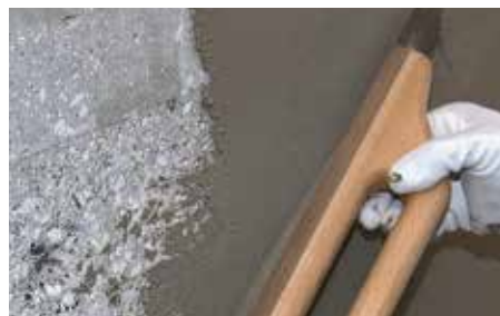
Applicazione di rasatura tissotropica a parete
