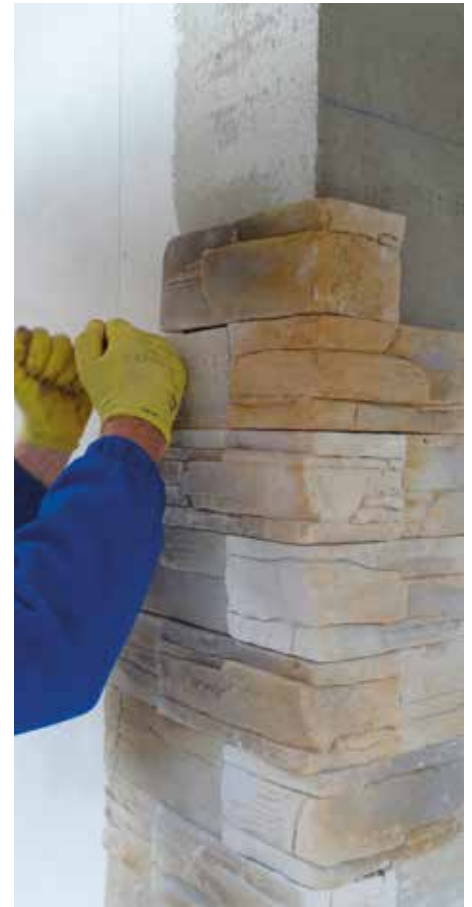
Posa di rivestimento con effetto "faccie a vista"
