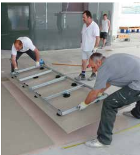
Movimentazione lastre sottili
