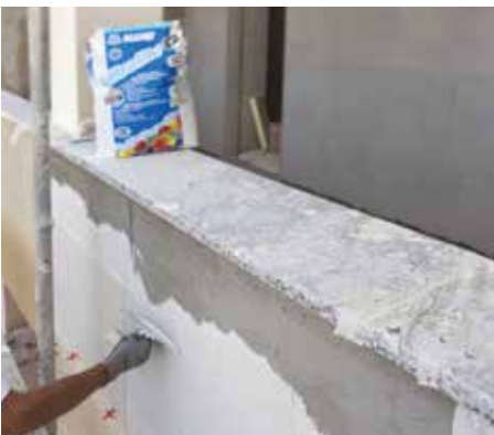
Stesura dell'adesivo sul supporto
