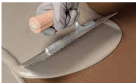
Applicazione di MAPELASTIC TURBO
