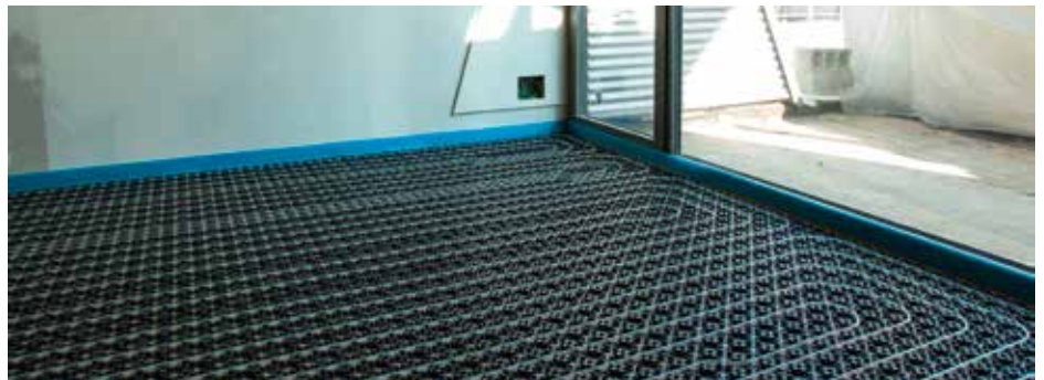
Sottofondo con impianto radiante a pavimento
