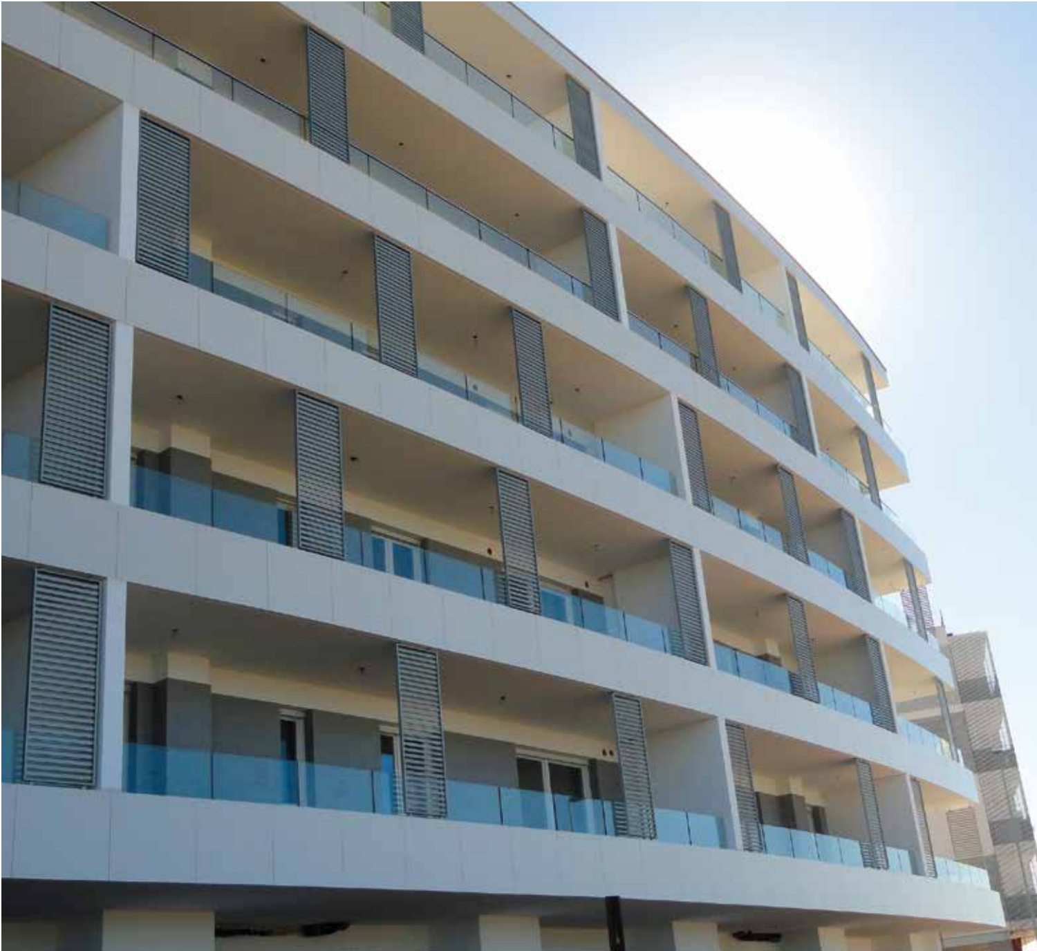
Posa di piastrelle sottili in facciata, condominio Sant'Anna, Bari
