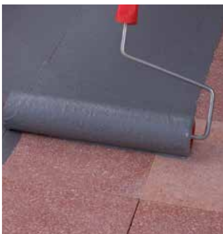
Applicazione di ECO PRIM GRIP su supporto non assorbente
