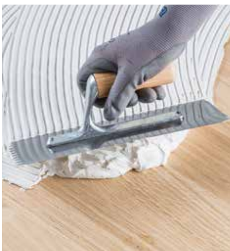
Posa di ceramica su pavimentazione in legno
