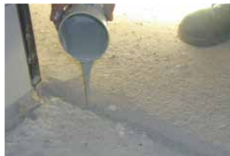
Sigillatura di fessure del sottofondo con EPORIP
