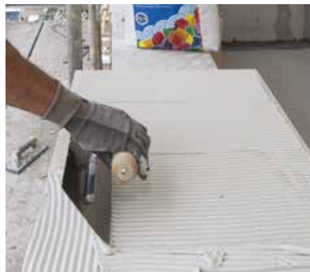
Stesura su adesivo su retro piastrella
