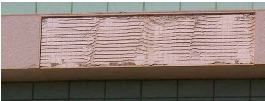
Posa effettuata in condizioni di esposizione al vento. L'adesivo ha formato la pelle e non si è trasferito sul rovescio della piastrella
