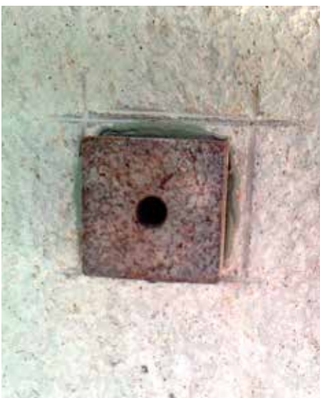
Incollaggio di provino per realizzazione di test di pull-off su intonaco
