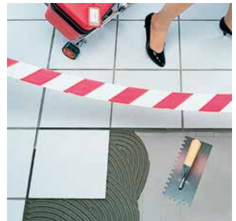
Posa rapida di ceramica in un centro commerciale
