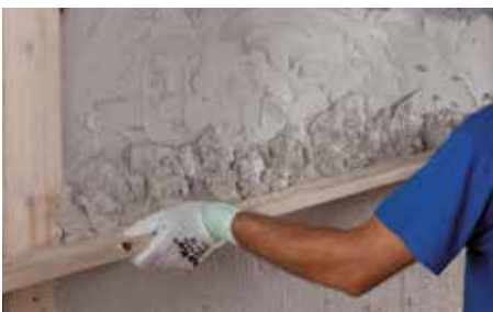
Applicazione di intonaco
