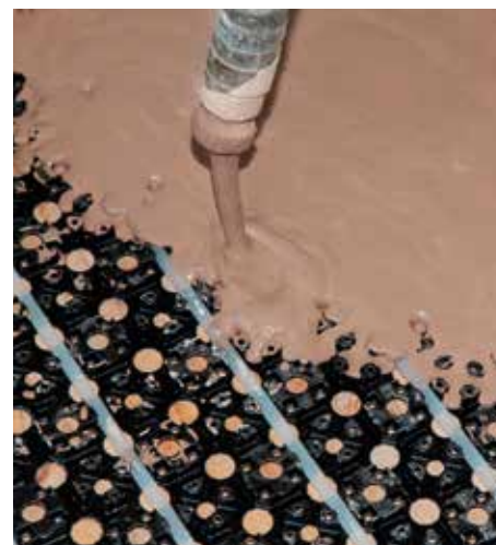
Realizzazione di sottofondo su impianto radiante a basso spessore
