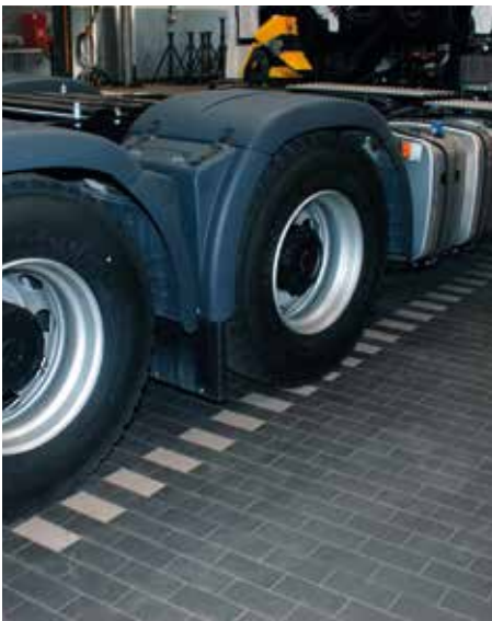
Pavimentazione sottoposta a carichi dinamici
