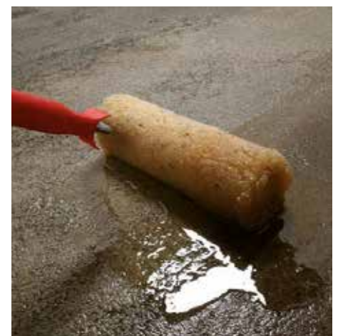
Applicazione di primer consolidante-impermeabilizzante
