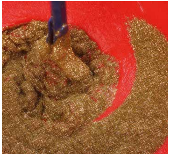
Miscelazione di KERAPOXY DESIGN con MAPEGLITTER
