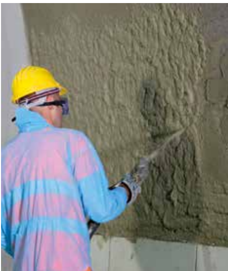
Applicazione a spruzzo dell'adesivo sul supporto di posa
