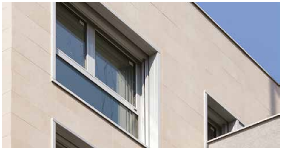
Posa di ceramica in facciata
