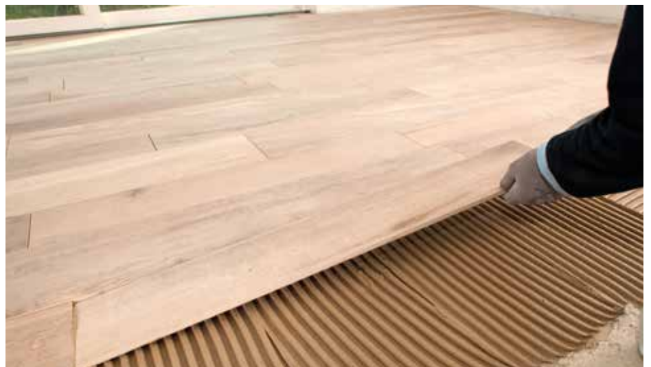
Posa di piastrelle di grande formato effetto legno
