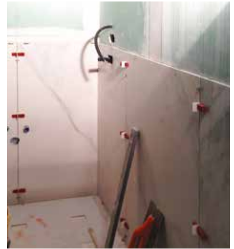
Posa di rivestimenti su pannelli in cartongesso
