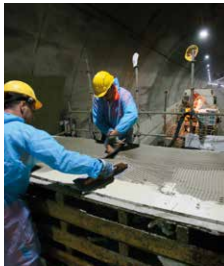
Stesura dell'adesivo sul retro delle lastre
