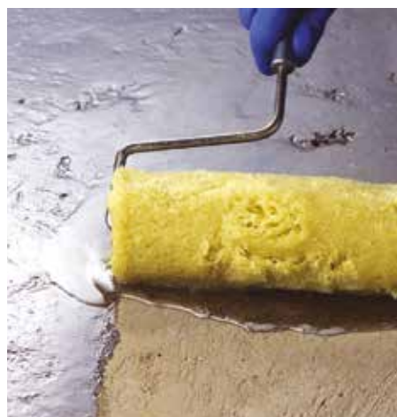
Applicazione di promotore di adesione su supporto assorbente
