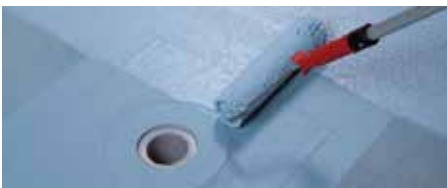
Stesura a rullo di MAPELASTIC AQUADEFENSE
