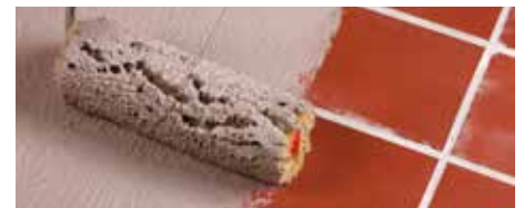
Applicazione di MAPELASTIC SMART
