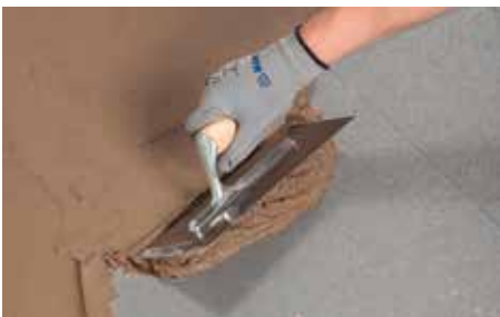
Applicazione di rasatura tissotropica a pavimento
