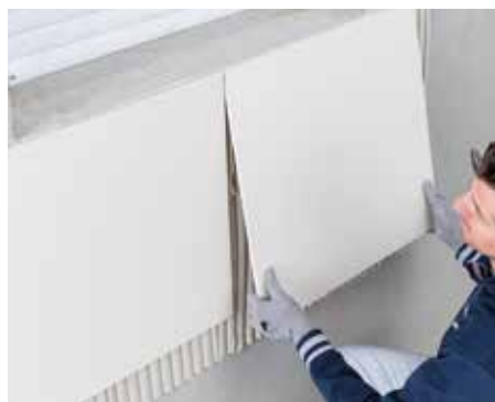
Posa di rivestimento in verticale con adesivo resistente allo scivolamento
