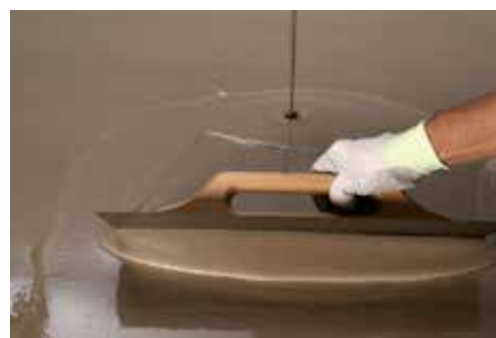
Applicazione di lisciatura autolivellante
