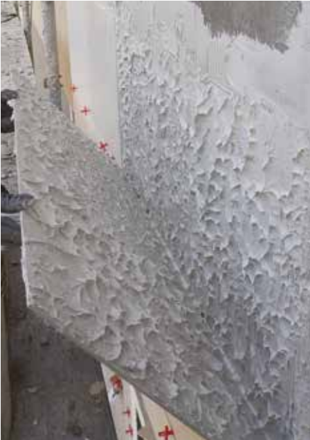
Verifica della completa bagnatura della lastra
