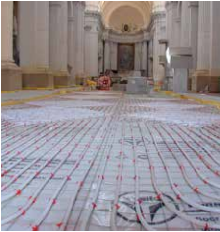
Installazione di tubazioni di un impianti radiante
