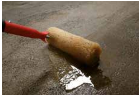
Applicazione di primer impermeabilizzante su sottofondo umido
