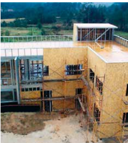
Struttura realizzata con pannelli in OSB
