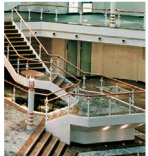
Posa di rivestimenti su supporti in metallo
