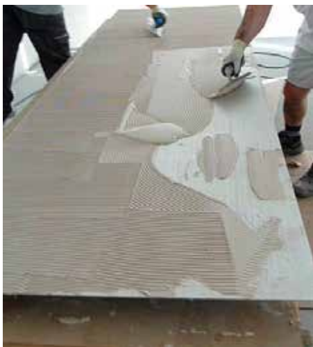
Doppia spalmatura della lastra sottile
