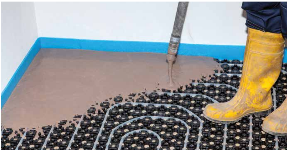
Realizzazione di sottofondo radiante a basso spessore mediante l'utilizzo di NOVOPLAN MAXI
