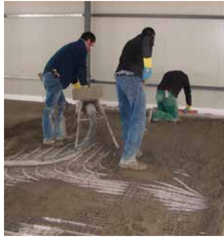
Realizzazione di sottofondo inglobante le serpentine dell'impianto radiante con TOPCEM PRONTO
