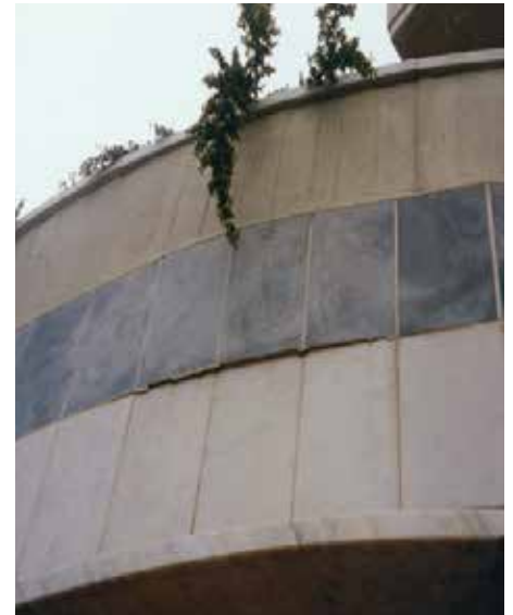
Dilatazione termica differenziale dipendente dal colore del rivestimento
