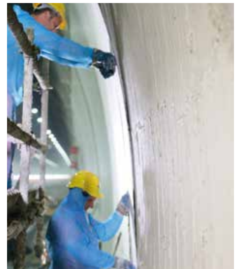
Messa in opera della lastra sul piedritto della galleria
