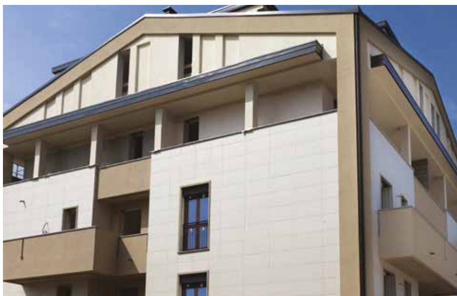
Posa di piastrelle su superfici esposte a irraggiamento solare mediante utilizzo di adesivi deformabili (classe opzionale S1-S2)
