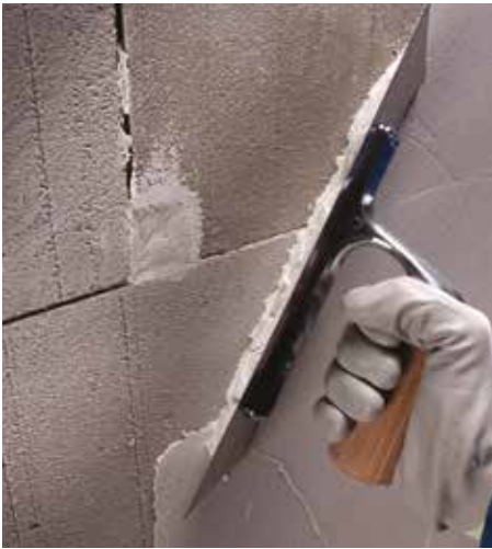
Applicazione di rasatura su blocchi in calcestruzzo alleggerito
