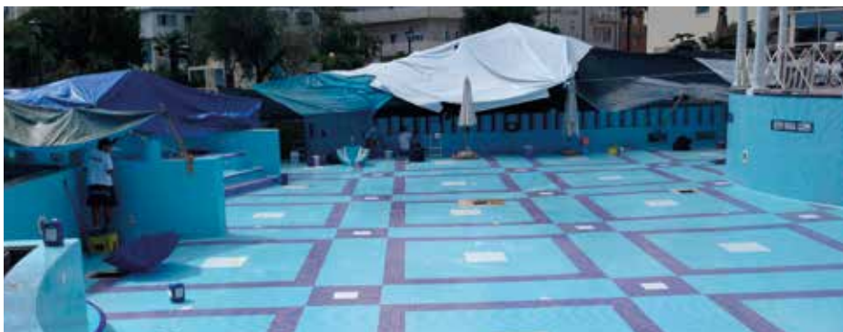
Posa effettuata in condizioni di esposizione al sole, le superfici devono essere protette dall'irraggiamento diretto in condizioni di temperatura elevata
