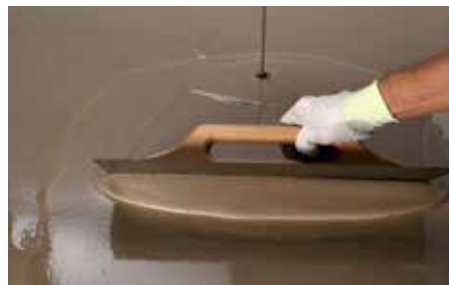
Applicazione di rasatura autolivellante
