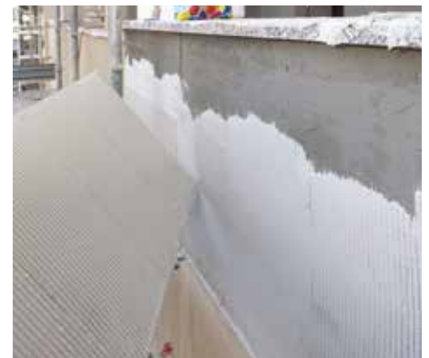
Installazione della lastra sottile
