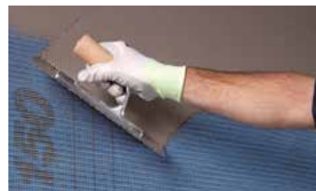
Applicazione di MAPELASTIC
