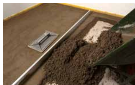
Realizzazione di massetto a ritiro controllato e veloce asciugamento con TOPCEM PRONTO
