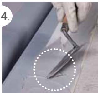
Per i giunti strutturali utilizzare **Mapeband TPE** incollato al supporto con **Adesilex PG4** e successivo spaglio di quarzo. La giunzione dei capi dovrà essere eseguita mediante **Adesilex LP** o saldatura a caldo
