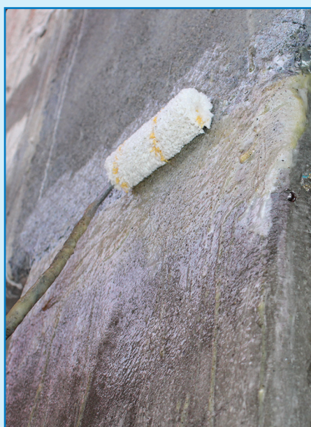
Application of MapeWrap Primer 1
