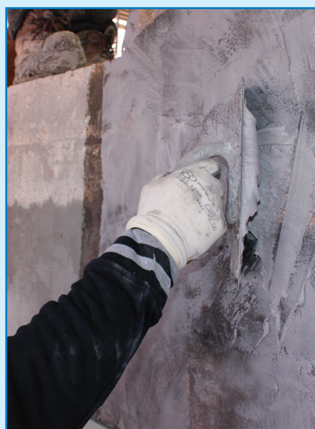
Skim-coat of MapeWrap 11 or MapeWrap 12
