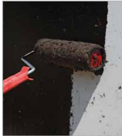
Fig. 7.51 – Using a roller to apply PLASTIMUL PRIMER
