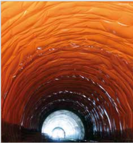
TUNNEL AUTOPISTA LLANO, Bogotá - Villavicencio, Colombia
