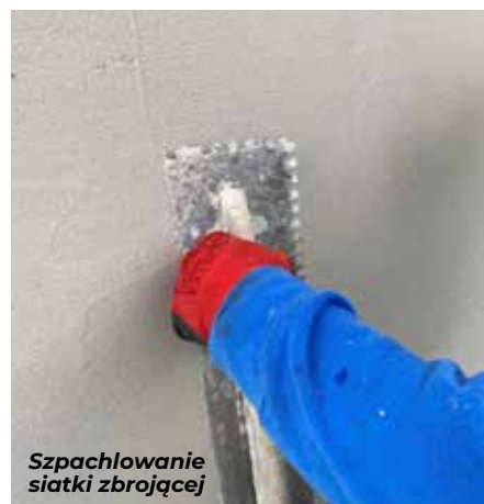
Wtapianie siatki zbrojącej w warstwę zaprawy
