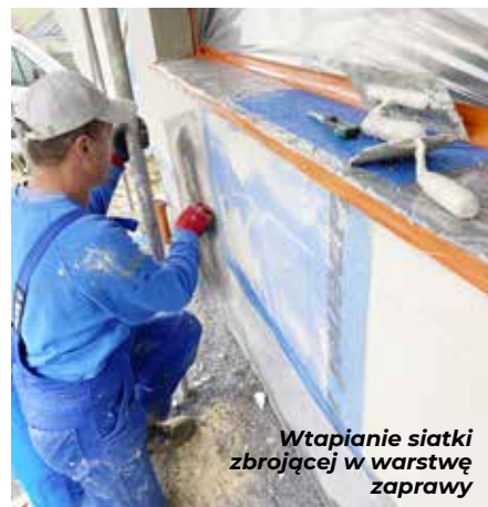
Nakładanie siatki zbrojącej na warstwę zaprawy
