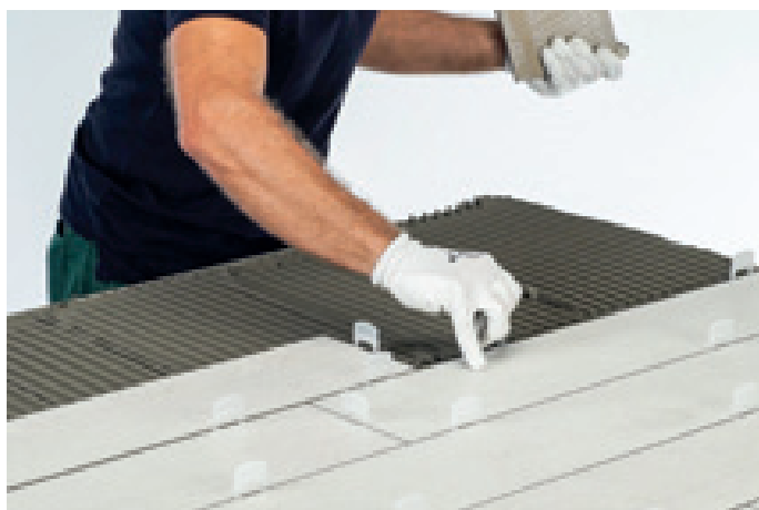
montaż klipsów jednorazowych
