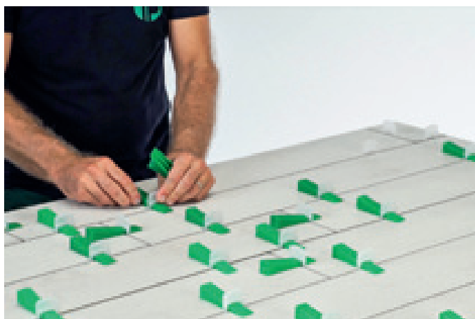
montaż klinów wyrównujących
