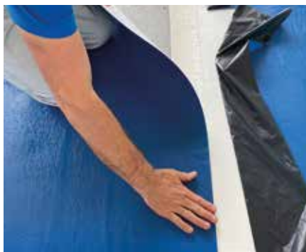
Wykonywanie zakładu między arkuszami membrany
