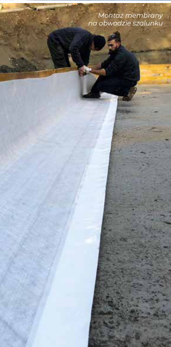
Hydroizolacja pali
