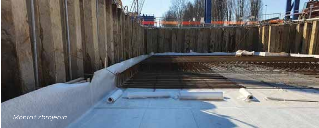
Realizacja w toku – przykład wykorzystania systemu hydroizolacji
