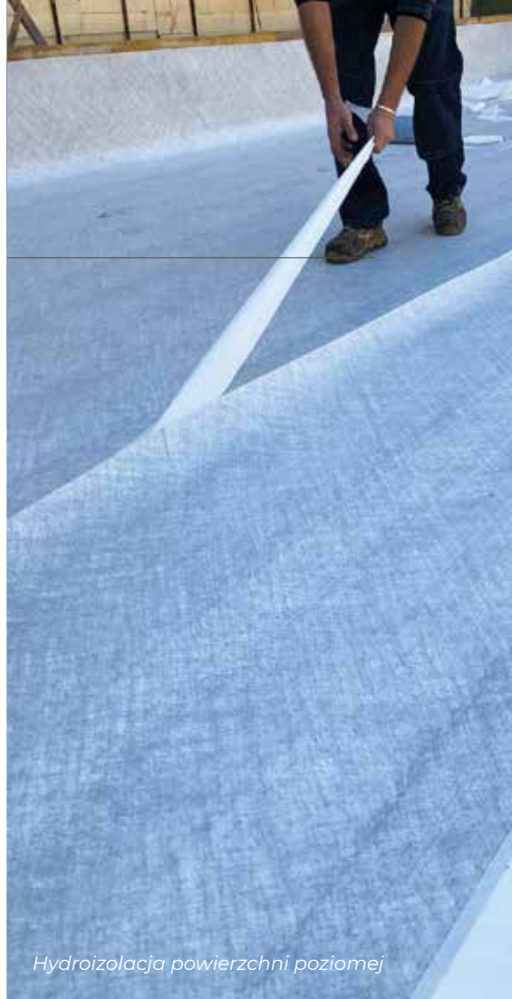
Montaż zbrojenia
