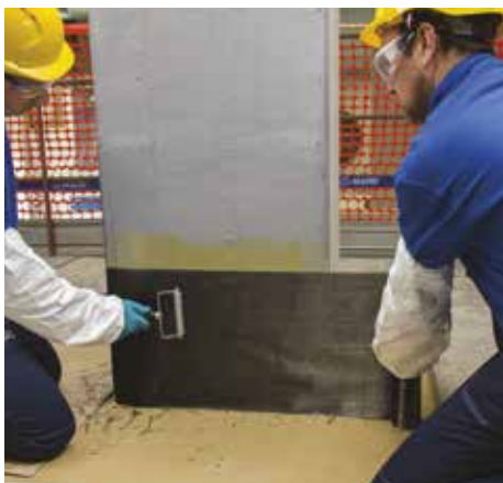
Nakładanie MapeWrap C UNI-AX
