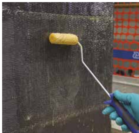
Nakładanie drugiej warstwy MapeWrap 31
