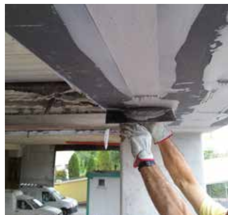
Nanoszenie kolejnej warstwy Adesilex PG1/Adesilex PG2
