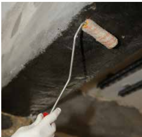
Nanoszenie MapeWrap Primer 1
