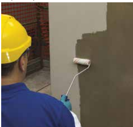
Nanoszenie MapeWrap Primer 1
