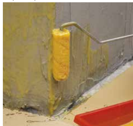
Nakładanie pierwszej warstwy MapeWrap 31
