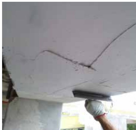
Nanoszenie Adesilex PG1/Adesilex PG2 na podłoże
