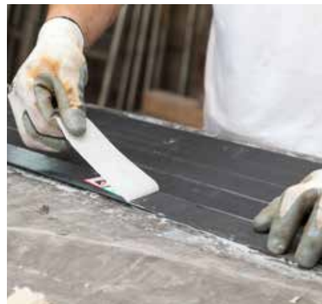
Zdejmowanie taśmy ochronnej z Carboplate
