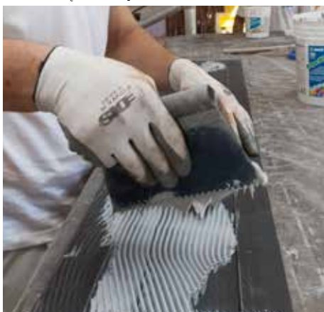
Nanoszenie Adesilex PG1/Adesilex PG2 na taśmę Carboplate
