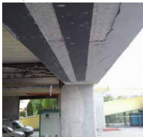
Mocowanie taśmy Carboplate
