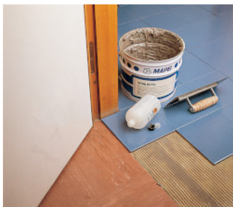
Nakładanie na stare podłoże z PVC
