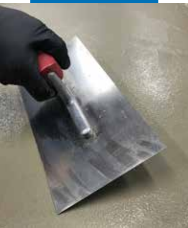
Rozprowadzanie zaprawy pacą metalową
