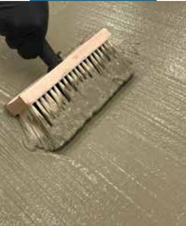
Rozprowadzanie zaprawy pędzlem
