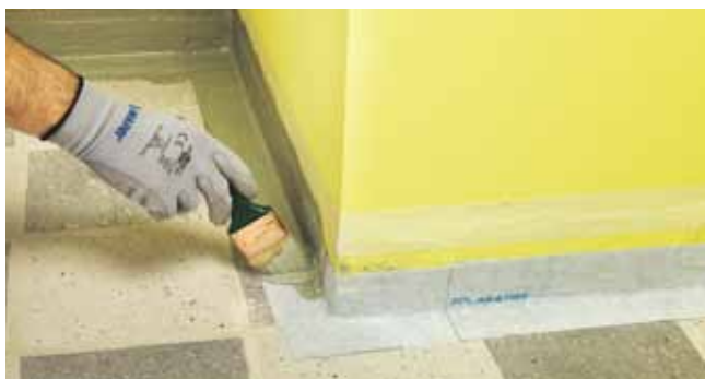
Applying Mapeband SA along edges
