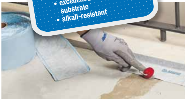
Applying Mapeband SA onto a screed
