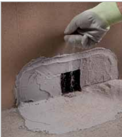
Fig. 5.39 - Sprinkling quartz on fresh ADÉSILEX PG4
