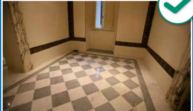
Posa su sottofondo conforme
