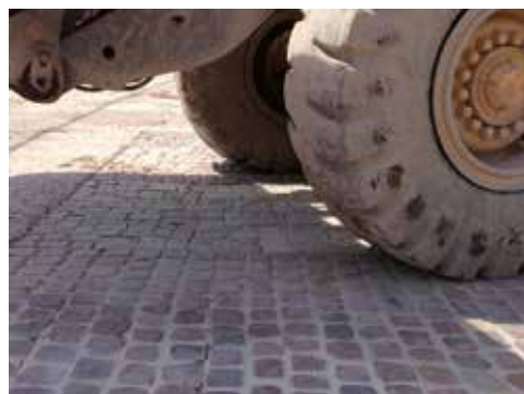
Esempio veicolare pesante: è richiesta la resistenza al traffico e al gelo
