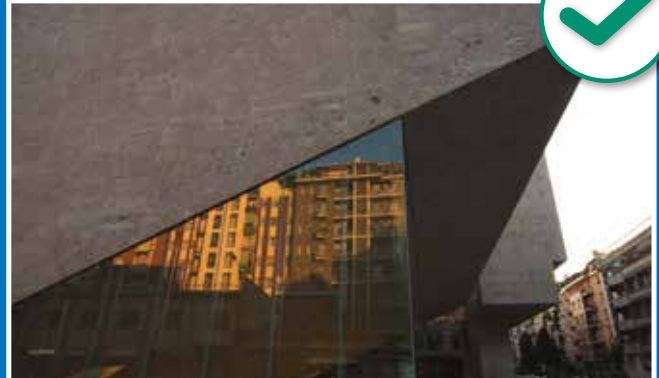
Posa su supporto conforme
