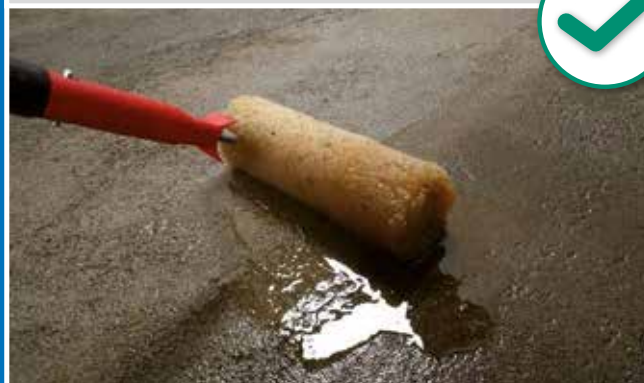
Intervento di ripristino con primer conforme a UNI 11515
