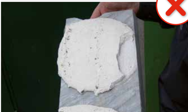
Posa non conforme
