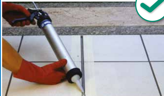
Realizzazione dei giunti conforme a UNI 11493
