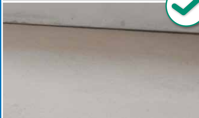
Massetto ripristinato conforme a UNI 11371
