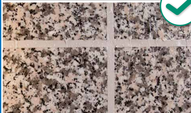
Sigillatura del giunto con materiale conforme alla norma
