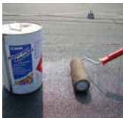
Applying the primer
