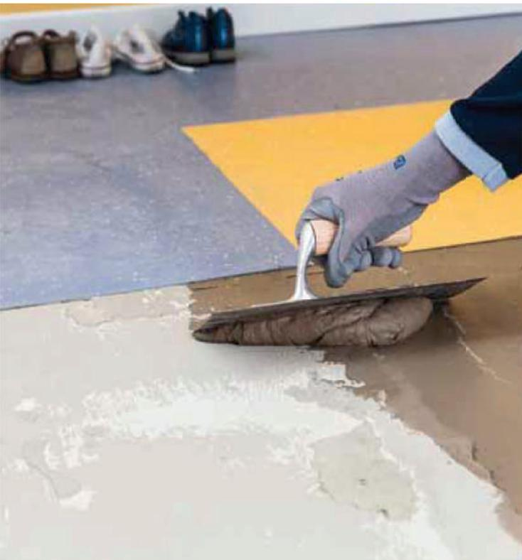
Argamassa cimentícia monocomponente espatulada de secagem rápida (30 a 60 minutos) e alto rendimento para preparação da base em espessuras finas ou tamponamentos de buracos e/ou rampeamentos pontuais em até 25 mm.
