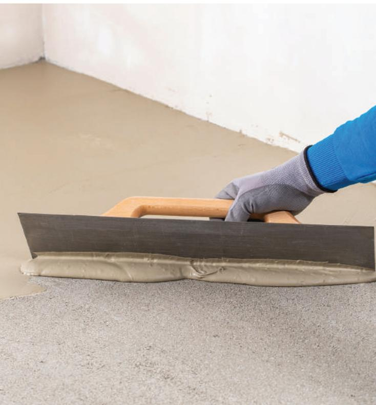
Argamassa cimentícia monocomponente para regularização espatulada, de secagem normal (aproximadamente 24 horas) e alto rendimento, para preparação de substratos cimentícios absorventes em camadas finas, em pisos e paredes, inclusive em áreas molhadas.
