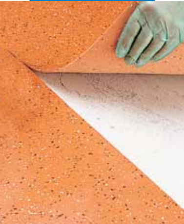
Assentamento de PVC com Adesilex G20
