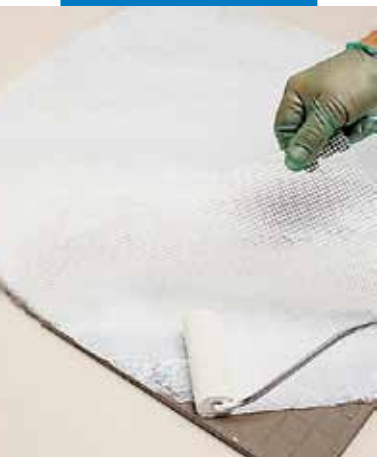
Colagem de tela de reforço no revestimento cerâmicos
