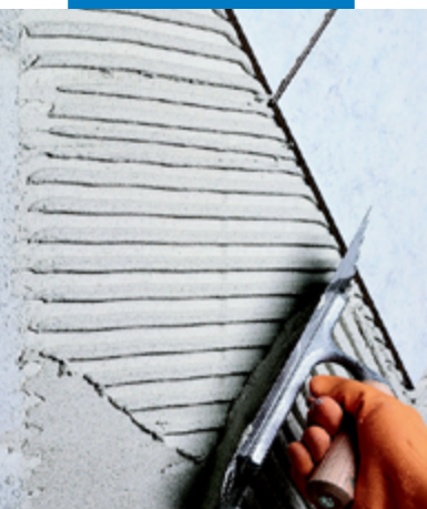
在膨胀泡沫混凝土墙上铺设单烧砖
