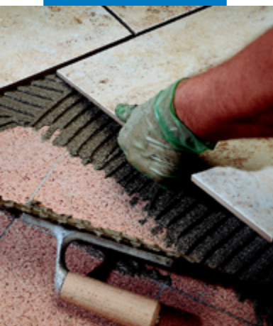
在外墙水磨石上粘贴单烧砖
