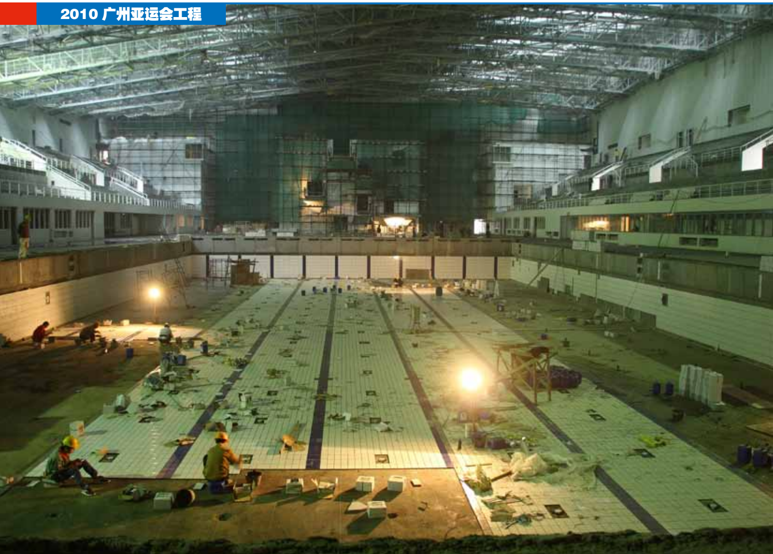
图 7. 游泳馆施工现场
