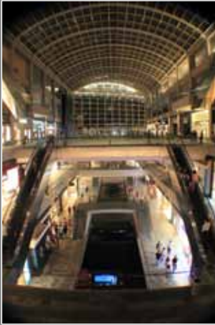
三层的购物中心都正在使用马贝瓷砖快胶 113 粘贴石板
