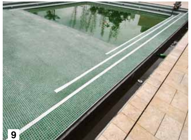
图 9 & 10. 以下的马贝产品被用于泳池：马贝墙面找平砂浆 151 (Nivoplan) + 马贝乳液 701 (Planicrete)、马贝快干找平砂浆 209 (Topcem Pronto)、马贝弹性防水砂浆 331 (Mapelastic)、马贝耐碱玻纤网 900 (Fibreglass Mesh)、马贝防水带 337 (Mapeband)、马贝锦砖胶 P10 (Adesilex P10)、马贝环氧填缝剂 141 (Kerapoxy)、马贝硅酮密封胶 A C (Mapesil AC)、马贝聚氨酯胶 122 (Keralastic)、马贝瓷砖胶 111 (Keracrete System)、马贝环氧填缝剂 141 (Kerapoxy)、马贝彩色防霉填缝剂 2801 (Ultracolor Plus)。
