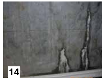
裂缝修补—湿裂
