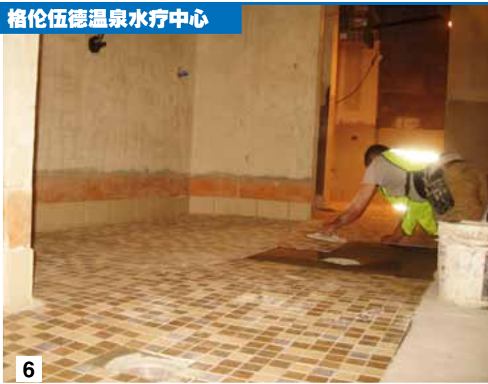
图 6 和 7. 用马贝瓷砖胶 101+ 马贝乳液 112 系统于健身区地面铺贴瓷砖，并用 OPTICOLOR 填缝剂填缝。图 8. 在疗养室或其他潮湿地方用 ULTRALITE MORTAR 铺贴瓷砖。
