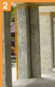
在柱子角落创建内圆角确保 MapeWrap G Uni-AX 能完全包裹。
