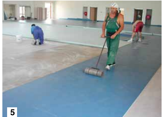
图 3. 施工前切割橡胶地板。 图 4. 以多用途，无溶剂和丙烯酸，有机化合物 (voc) 挥发量极低的水性胶粘剂马贝环保胶 V4SP 安装橡胶地板。 图 5. 铺贴橡胶地板后，再以滚筒滚压，确保能与基面完好粘合。
