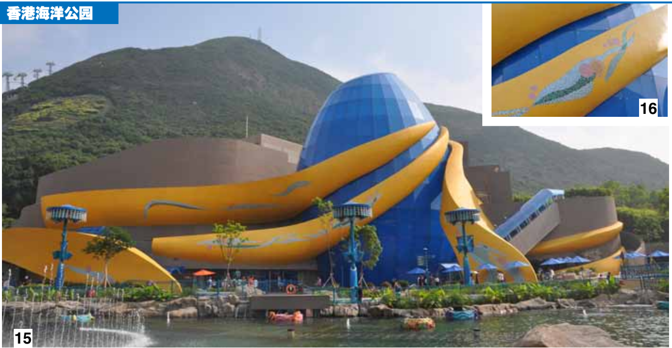
图 15 和 16. “海洋奇观”外墙采用马贝聚氨酯胶 122T 安装一系列马赛克砖。
