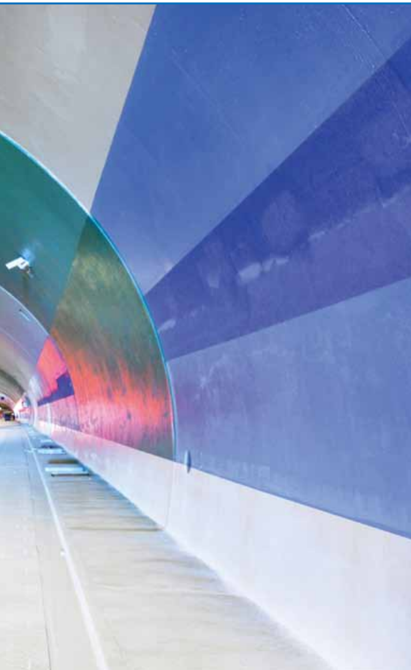
图 4 和 5. 最终面层用马贝弹性彩漆 329 处理。
