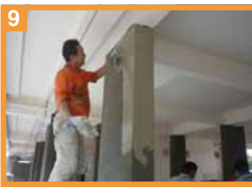
在抹灰层面上再铺涂一层腻子
