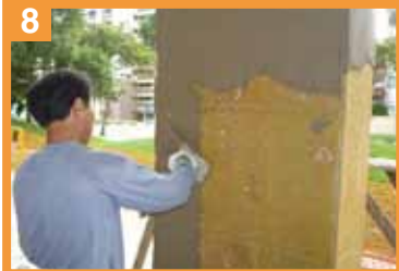
在柱面上作抹灰处理
