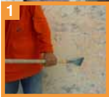
从支柱中清除旧漆 / 涂料 / 石膏
