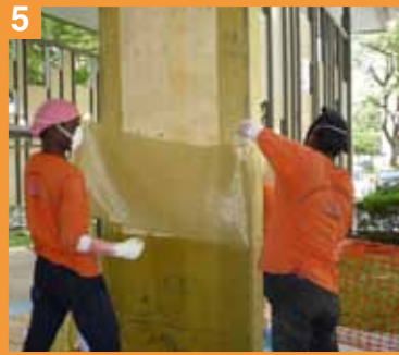
将浸透 MapeWrap G Uni-AX 玻璃纤维织物铺设在未干的柱面墙上。
