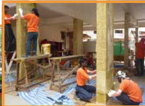
将浸透 MapeWrap G Uni-AX 玻璃纤维织物铺设在未干的柱面墙上。
