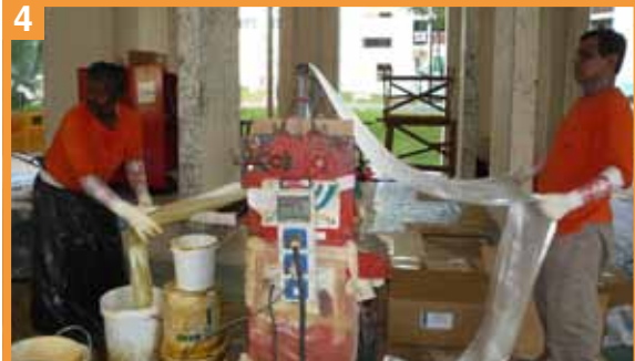
当界面剂仍处于未干状态时，在浸渍机上采用 MapeWrap 31 SP 浸透 MapeWrap G Uni-AX 玻璃纤维织物
