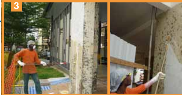
用 MapeWrap 31 SP 环氧树脂涂于准备基面上
