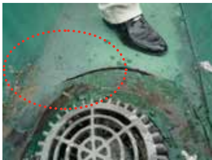
雨水斗边缘卷材开裂。
