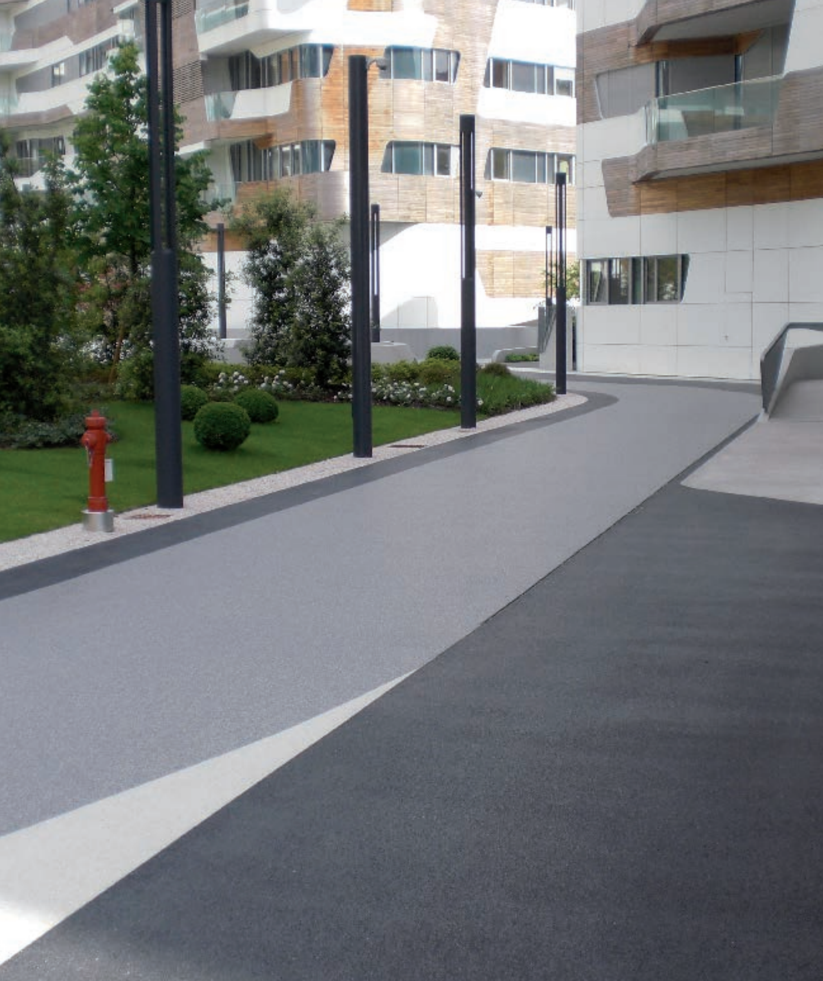
Vías que conectan las residencias - City Life - Milán - Productos utilizados: MAPEFLOOR URBAN SYSTEM
