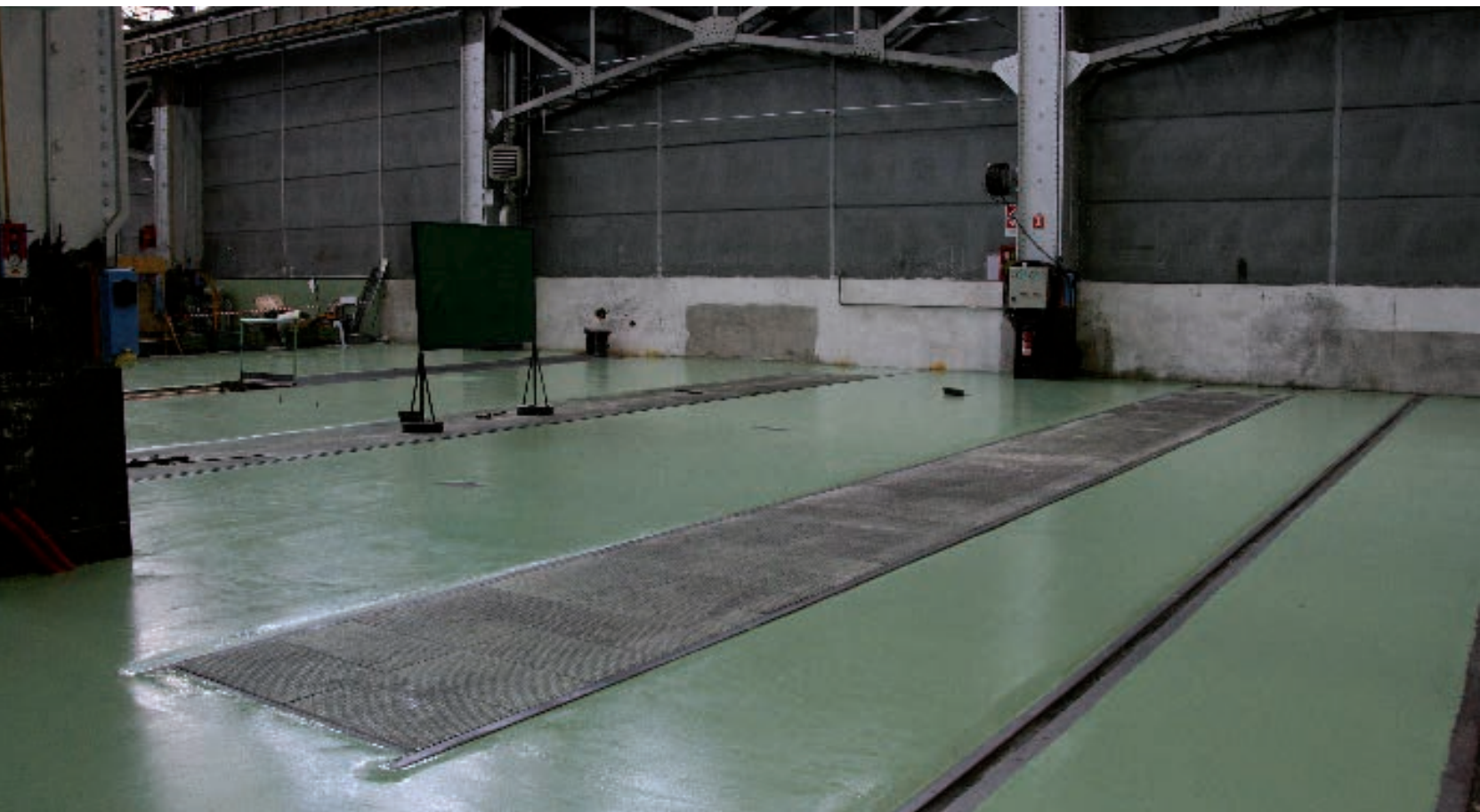
Almacenes OGR - Foligno (PG) - Italia Productos utilizados: Mapefloor System 31 Mapefloor System 91
