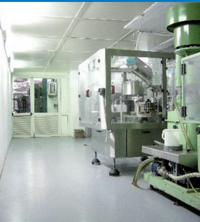
Oleificio Gargiulo - Sant'Agnello (NA) - Italia Productos utilizados: Mapefloor System 32
