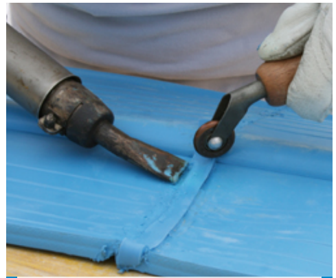
f) aplique una tira de PVC para reforzar el resto de sección soldada
