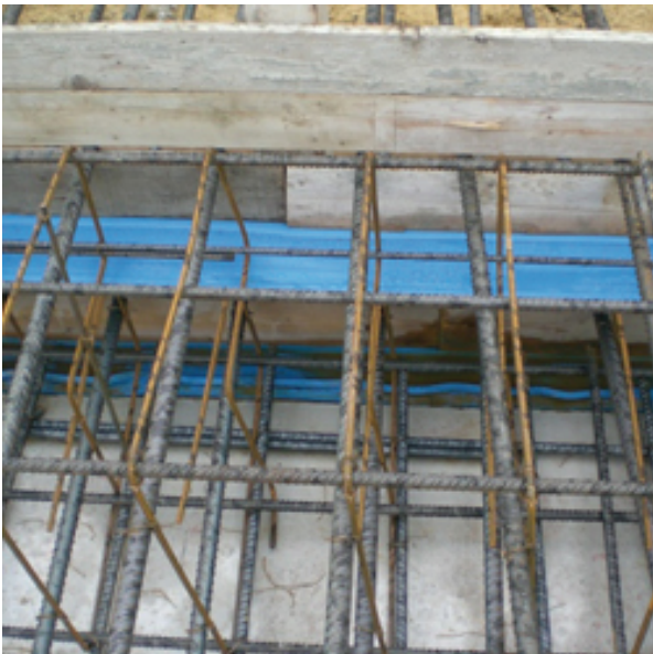
Sellado de una junta estructural en una cimentación
