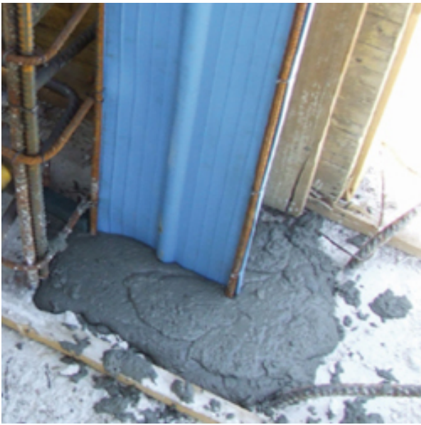
Idrostop PVC BI embebido en la losa de cimentación con Planigrout, tras demoler parte de la losa
