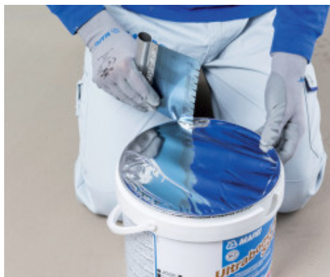
Gedeeltelijke verwijdering van de afdichting verlengt de verwerkingstijd
