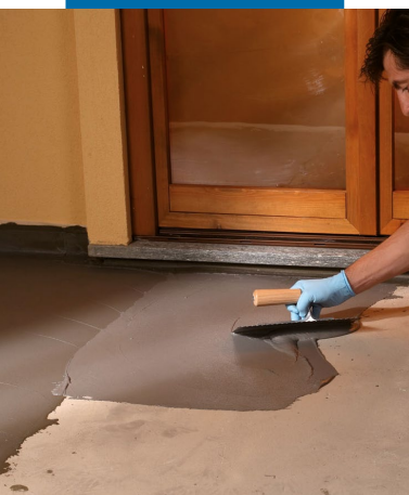
Impermeabilización de estructura de concreto con llana
