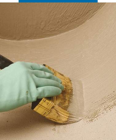
Impermeabilización de muro de cimentación con brocha
