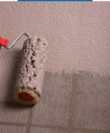
Impermeabilización de muro de cimentación con rodillo
