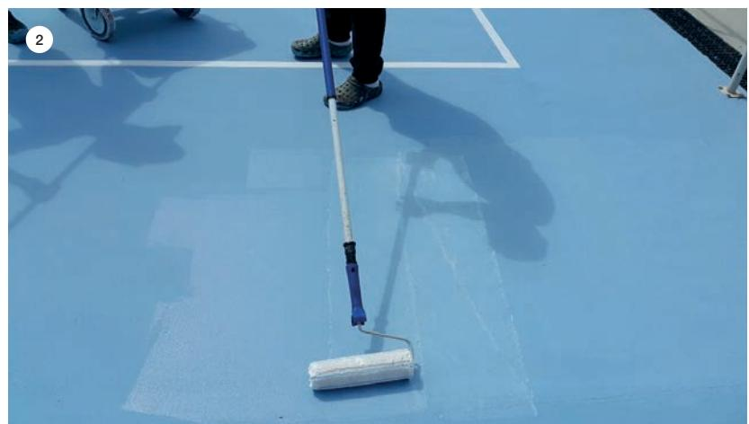
**SLIKA 1:** Nanošenje temeljnog premaza MAPECOAT I 600 W, za zatvaranje pora u gumenoj podlozi te za poboljšanje prionjivosti narednih slojeva.
