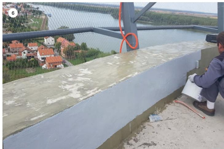
**SLIKA 1:** Reprofilacija mortom PLANITOP SMOOTH&REPAIR R4.
