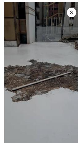
**SLIKA 1:** Kamena podloga pripremljena za nanošenje morta za sanaciju.
