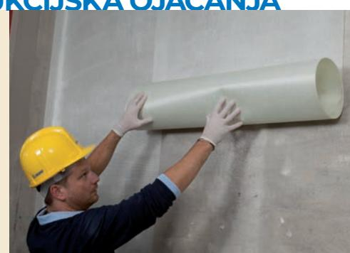
MAPEWRAP EQ SYSTEM preporučuje se za popravak i ojačanje nenosivih zidova i sekundarnih strukturnih elemenata radi boljeg raspoređivanja naprezanja i veće duktilnosti u slučaju potresa.
