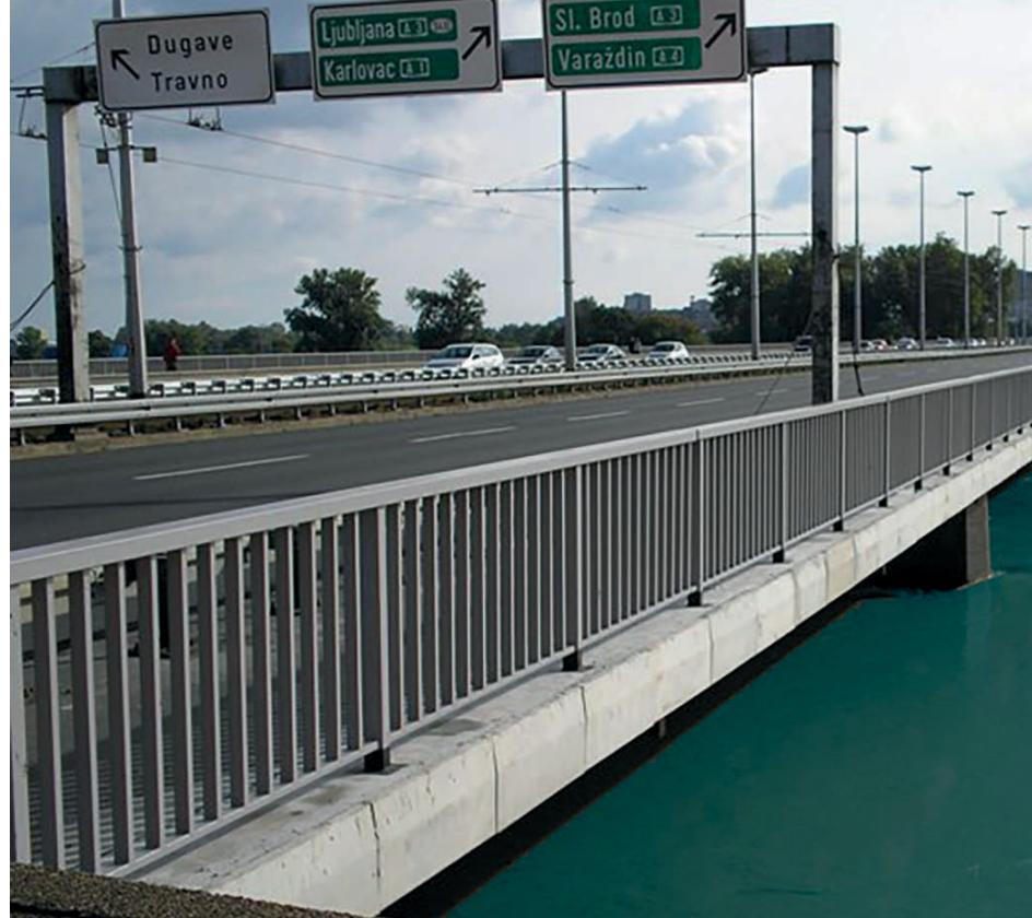
degradirani slojevi te je izvršena reprofilacija betona – kolničke ploče, stupova, stubišta, vijenaca i hodnika mosta, a sanirana je i odvodnja te je postavljena nova ograda mosta. Radovi na pripremi površina za sanaciju započeli su frezanjem postojećeg asfalta, hidrodemoliranjem degradiranih betonskih dijelova te uklanjanjem postojeće dotrajale odvodnje i ležajeva mosta.
