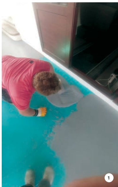
SLIKA 1: Ugradnja poliuretanskog laganog estriha MAPEDECK LITESCRED.
