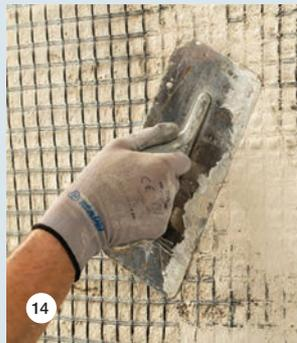
sustava visoke duktilnosti, poput sustava FRG (*Fiber Reinforced Grout*), osnovni je vezni materijal mort na bazi hidrauličkih veziva s pucolanskim djelovanjem, a kompozitni dio za ojačanje su vlakna u obliku mreže od staklenih, karbonskih ili bazaltnih vlakana.
