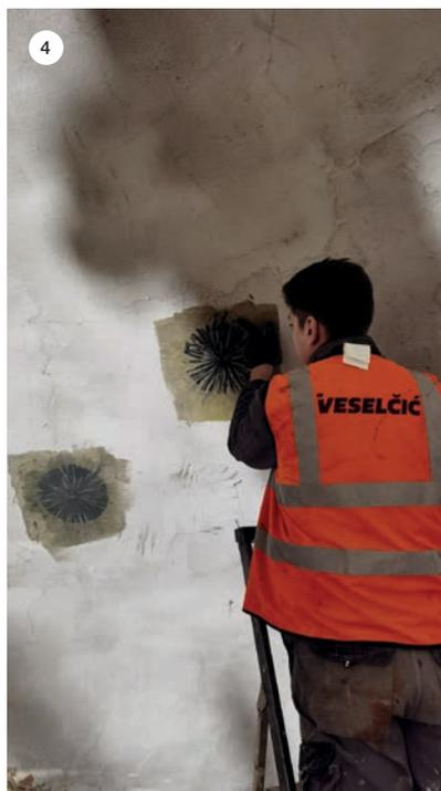
**SLIKA 1:** Izvođenje FRCM sustava – polaganje tkanine MAPEWRAP C UNI-AX 600 na izvedeni sloj duktilnog bescementnog morta PLANITOP HDM RESTAURO.
