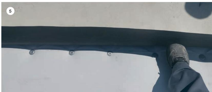
**SLIKA 1:** Obrada atike prije ostavljanja sintetičke FPO folije.
