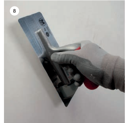
SLIKE 7 i 8: Nanošenje fine žbuke MAPE-ANTIQUE FC ULTRAFINE izvodi se ravnim metalnim gleterom u dva sloja.
