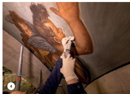
SLIKA 4: Injektiranje viskozne mase MAPE-ANTIQUE F21 na površinu zida s freskama.
