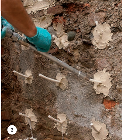
SLIKA 3: Injektiranje hidrauličkog veziva MAPE-ANTIQUE I pumpom pod niskim tlakom.
