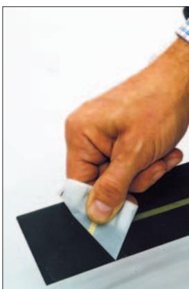
Obr. 16: Snímání ochranné fólie z CARBOPLATE
