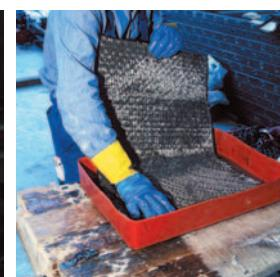
Obr. 12: Ruční impregnace MAPEWRAPu C
