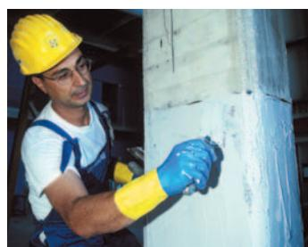
Obr. 11: Vyrovnání povrchu pomocí MAPEWRAPu 11 a MAPEWRAPu 12
