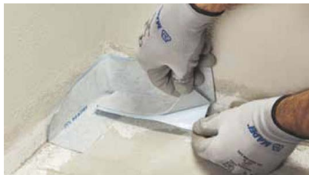
Aplikace Mapebandu SA v rozích
