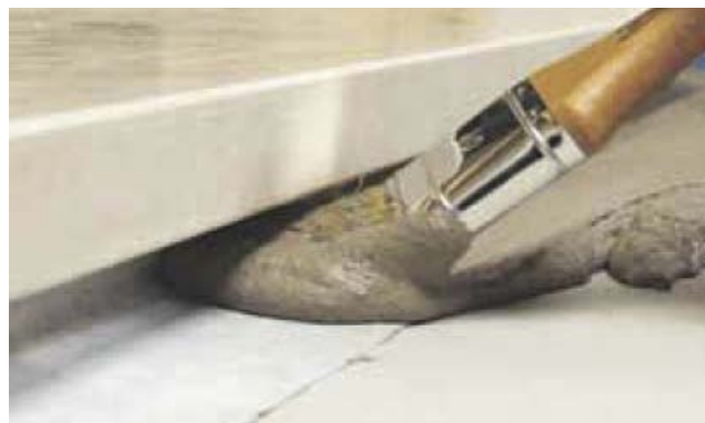
Aplikace Mapebandu SA v problematických prostorách, např. ve dveřních otvorech
