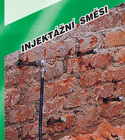
**MAPESTOP** – koncentrovaná injektážní mikroemulze (velikost částic 20–60 µm) na bázi silanů a siloxanů ke zhotovení chemické clony proti vznájící vlhkosti u neizolovaného zdíva. Ředí se v poměru 1 díl **MAPESTOPU** a 15–19 dílů vody.
