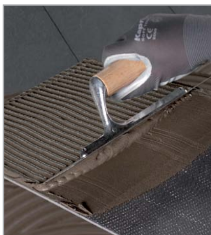
Obr. 7.2 – Pokládka dlažby: nanášení lepidla na rubovou stranu obkladového prvku
