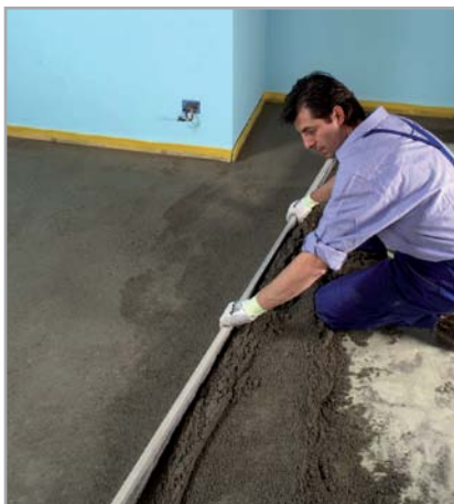
Obr. 4.5 – Vyrovnání směsi TOPCEM PRONTO stahovací latí
