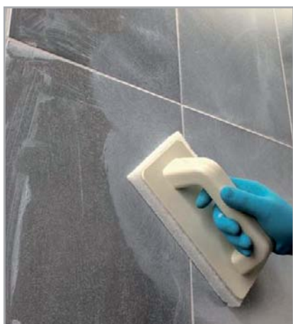
Obr. 7.24 – Čištění obkladu s použitím Scotch Brite®
