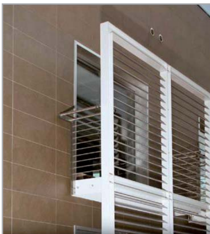
Obr. 7.13 – Ukázka instalace tenkovrstvých obkladů na fasádě
