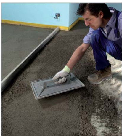
Obr. 4.6 – Zhutnění a vyhlazení povrchu potěru TOPCEM PRONTO
