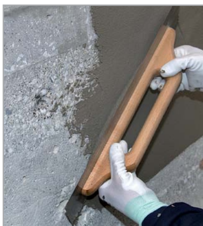
Obr. 5.6 – Vyrovnávání stěny stěrkou PLANITOP FAST 330
