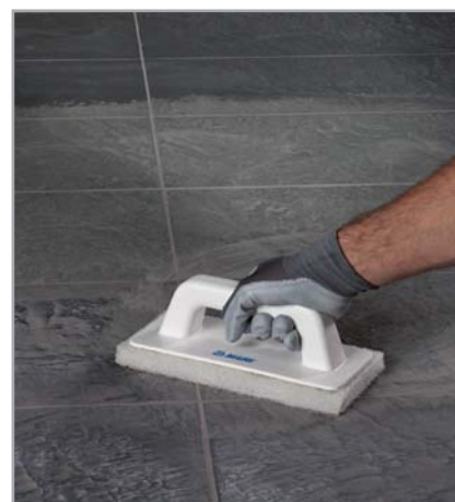
Obr. 7.21 – Čištění s použitím Scotch Brite®
