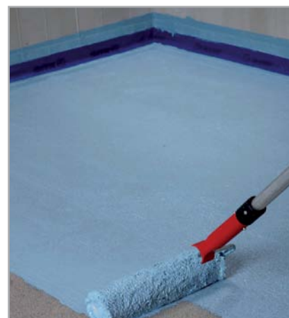
Obr. 6.2 – Aplikace MAPELASTIC AQUADEFENSE válečkem na podlahu
