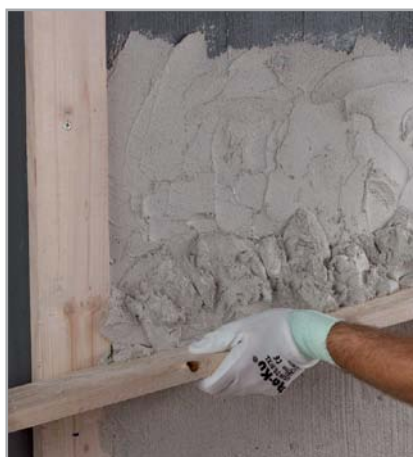
Obr. 5.5 – Vyrovnávání betonové zdi omítkou NIVOPLAN + PLANICRETE
