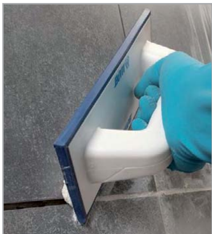
Obr. 7.23 – Spárování obkladu s použitím výrobku FLEXCOLOR
