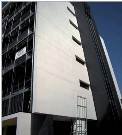
Obr. 7.12 – Ukázka instalace tenkovrstvých obkladů na fasádě
