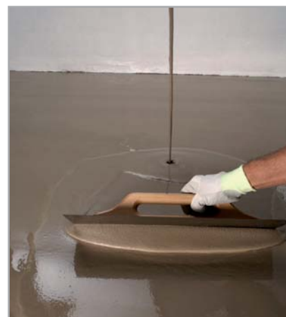
Obr. 5.2 – Vyhlazení povrchu cementového potěru s použitím výrobku ULTRAPLAN
