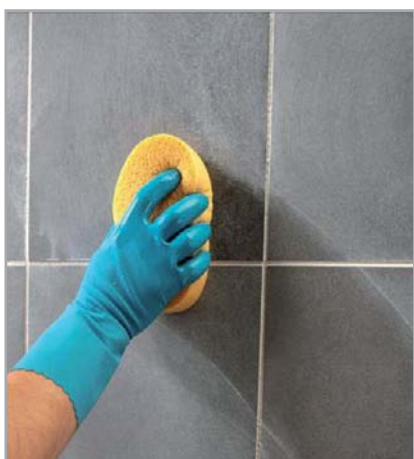
Obr. 7.25 – Dokončení povrchu spár houbou
