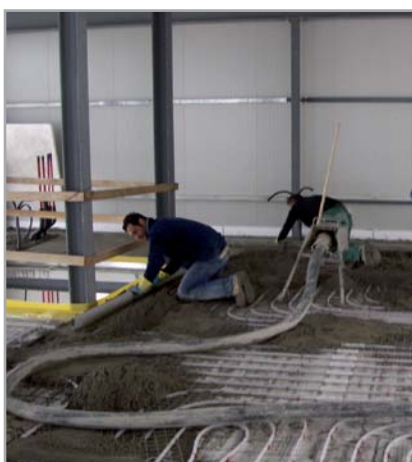
Obr. 4.7 – Provádění topného potěru s použitím směsi TOPCEM PRONTO
