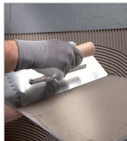
Obr. 7.5 – Lepení obkladů: nanášení lepidla na rubovou stranu obkladového prvku
