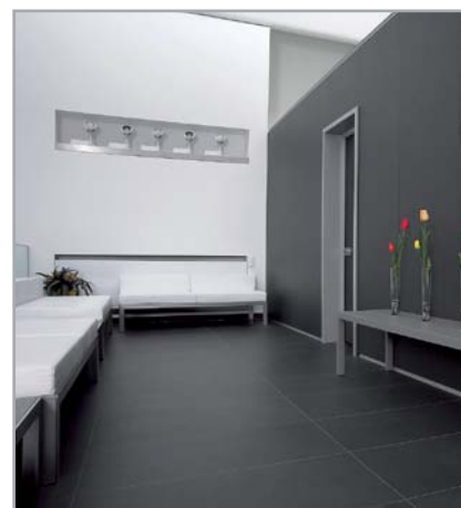
Obr. 7.11 – Ukázka pokládky tenkovrstvých obkladů a dlažeb typu gres v interiéru
