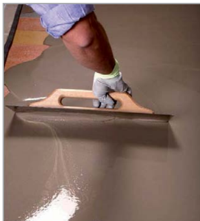
Obr. 5.4 – Vyrovnávání povrchu staré dlažby z terazza stěrkou ULTRAPLAN
