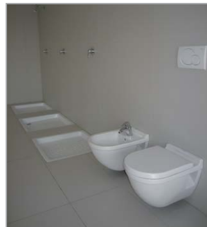
Obr. 7.14 Ukázka instalace tenkovrstvých obkladů a dlažeb na hydroizolační systém
