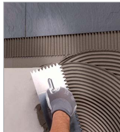
Obr. 7.4 – Lepení obkladů: nanášení lepidla zubovou stěrkou č. 6
