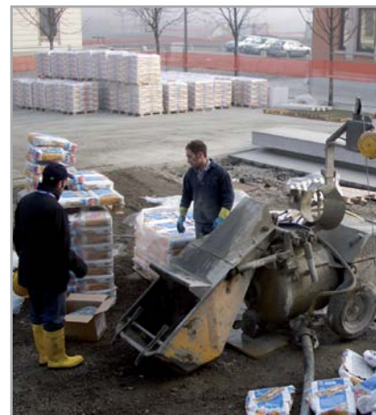
Obr. 4.2 – Příprava TOPCEMU PRONTO a přeprava pneumatickým čerpadlem
