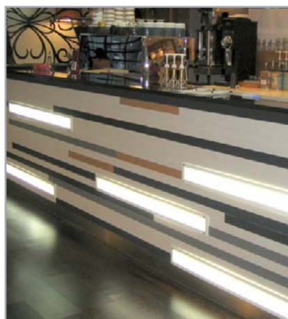
Obr. 7.17 – Ukázka instalace tenkovrstvých obkladů a dlažeb typu gres na podklad ze dřeva
