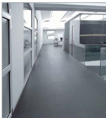
Obr. 7.8 – Ukázka pokládky tenkovrstvé dlažby typu gres v interiéru
