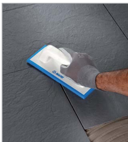
Obr. 7.3 – Pokládka dlažby: pokládka a přitlačení obkladových prvků
