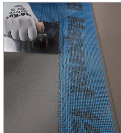
Obr. 6.1 – Aplikace MAPELASTIC + MAPENET 150 na podlahu
