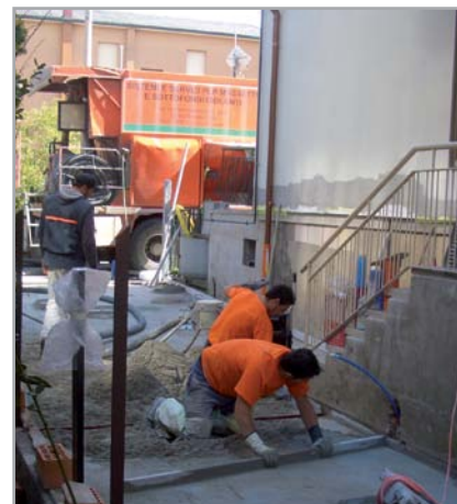
Obr. 4.4 – Mechanizovaný systém se sílem umístěným na automobilovém podvozku pro skladování, přípravu a dopravu namíchaného TOPCEMU PRONTO
