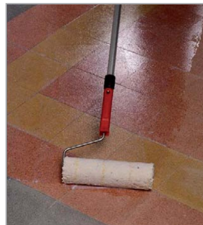
Obr. 5.3 – Aplikace ECO PRIM T válečkem na stávající dlažbu z terazza před vyrovnáním povrchu
