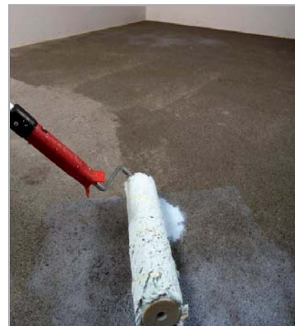
Obr. 5.1 – Aplikace PRIMERU G ředěného v poměru 1:1 válečkem na cementový potěr před vyrovnáním povrchu
