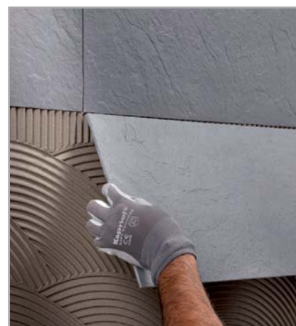
Obr. 7.6 – Lepení obkladů: instalace obkladu
