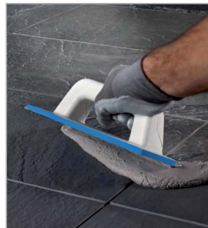
Obr. 7.20 – Výplň spár ULTRACOLOREM PLUS
