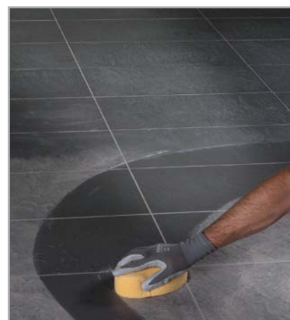
Obr. 7.22 – Čištění spárovaného povrchu houbou
