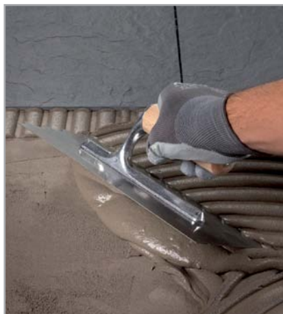
Obr. 7.1 – Pokládka dlažby: nanášení lepidla zubovou stěrkou s 9 mm kulatými zuby
