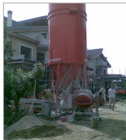
Obr. 4.3 – Mechanizovaný systém se sílem pro skladování, přípravu a dopravu namíchaného TOPCEMU PRONTO
