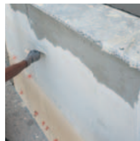
Aplikace Ultralite S2 Quick na omítku
