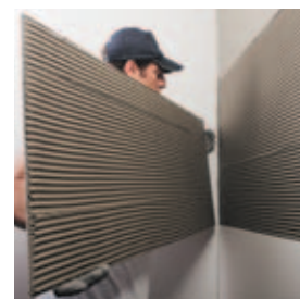
Instalace tenkovrstvého obkladu na stěnu
