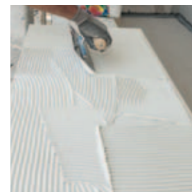
Aplikace Ultralite S2 Quick na rubovou stranu obkladového prvku
