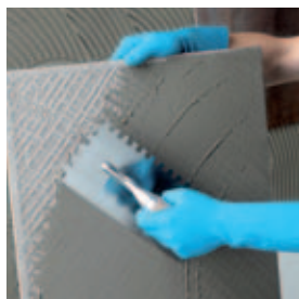
Aplikace lepidla na rubovou stranu obkladového prvku
