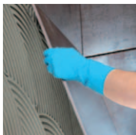
Instalace velkoformátových keramických obkladů na stěnu
