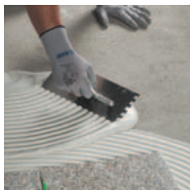
Aplikace Ultralite S1 Quick zubovou stěrkou
