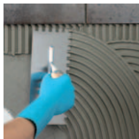
Aplikace Ultralite S1 zubovou stěrkou
