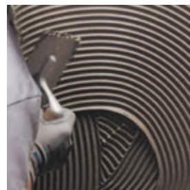
Aplikace Ultralite S2 na omítku
