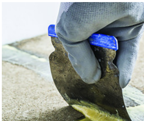
Přebytky výrobku rovnoměrně rozetřete a důsledně vyplňte trhlinu
