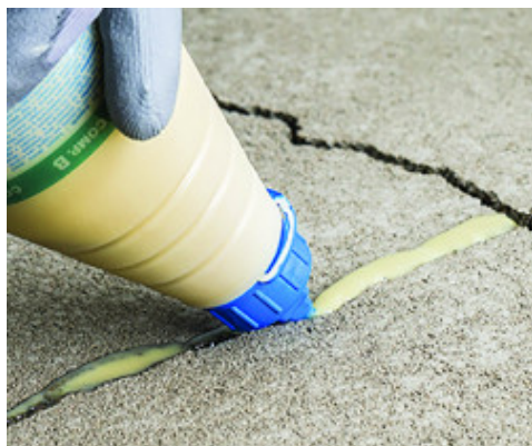
S použitím trysky aplikujte výrobek přímo do trhliny
