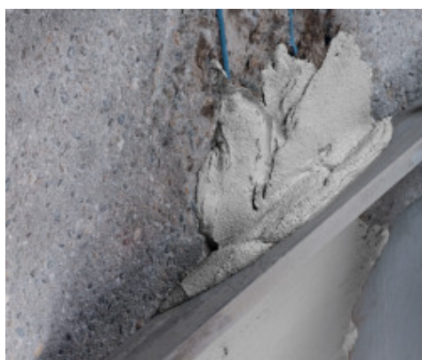
Stahování směsi Planitop Rasa & Ripara hliníkovou latí
