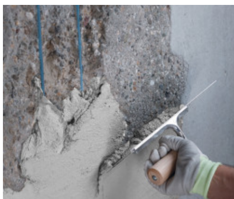
Nanášení směsi Planitop Rasa & Ripara hladítkem
