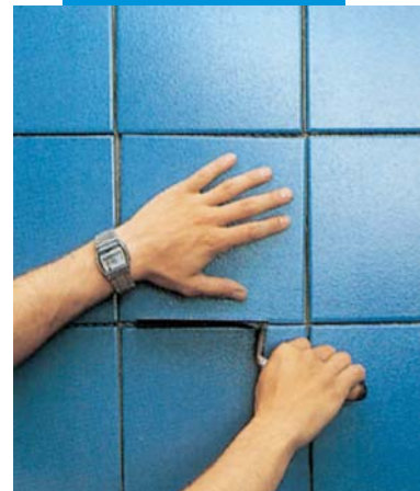
Doba, po kterou je možno provádět opravy je cca 45 minut
