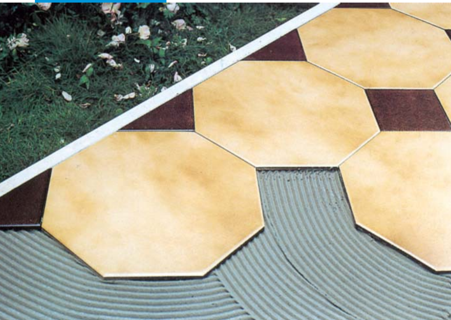
Pokládání venkovní dlažby (Kerabond + Isolastic)
