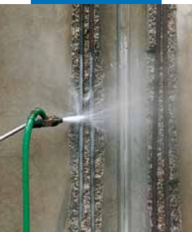
Čištění ocelové výztuže
