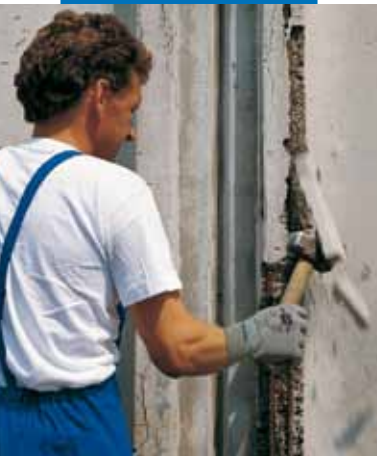
Odstraňování poškozeného betonu
