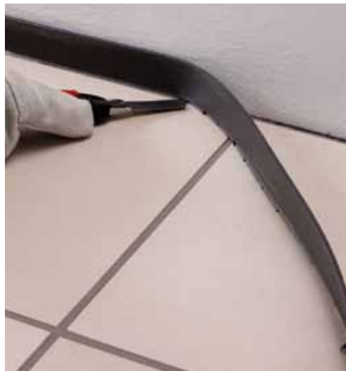
Po vytvrzení spárovací hmoty odřízněte vystupující částí Mapesonicu Strip
