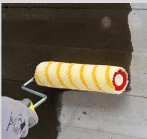
Påføring af Planiseal WR 100 med rulle
