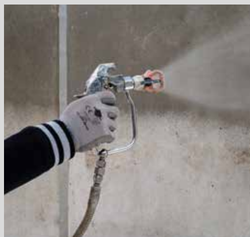
Påføring af Planiseal WR 100 med sprøjtepistol
