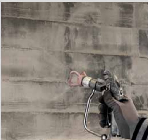
Påføring af Planiseal WR 90 Gel med sprøjtepistol
