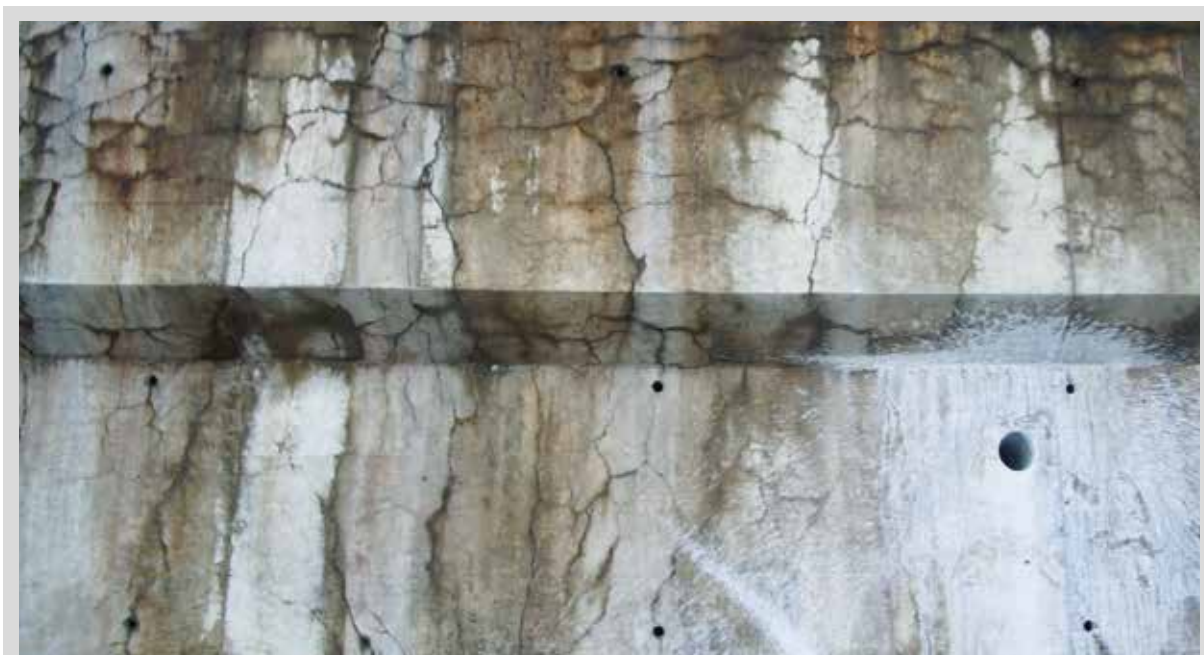
Typisk eksempel på alkali-aggregat-reaktion
