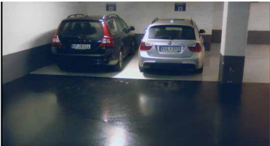
Teatergaragen i Malmø, Mapefloor PU system.
