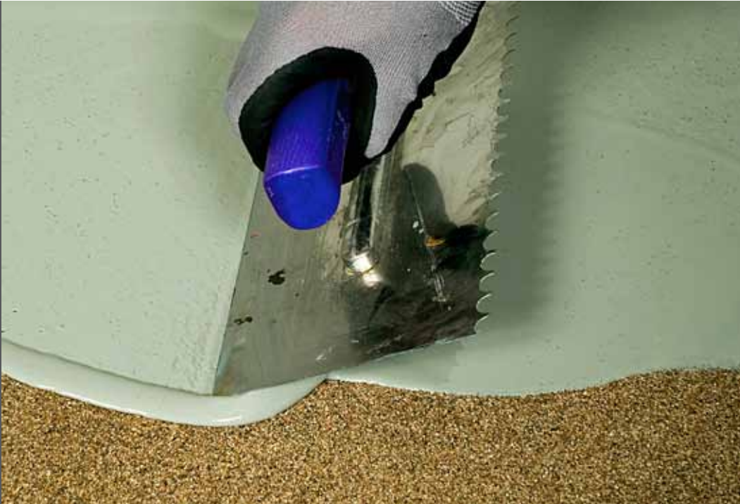
Påføring af revneoverbyggende membran i parkeringshuse
