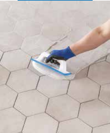
Fugning med Keracolor GG og MAPEI pudsebræt
