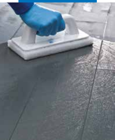
Rengöring av kakelfogar med Scotch-Brite® när produkten delvis har härdat
