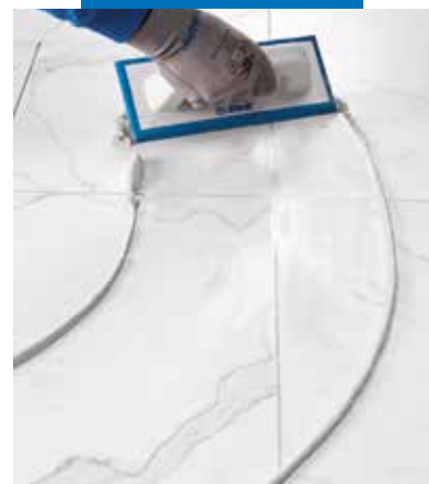
Applicering av Ultracolor Plus på marmor med gummispackel
