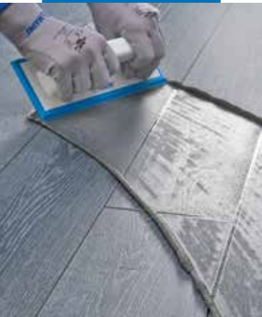
Fogning av Ultracolor Plus med gummispackel på klinker med trä-stuktur
