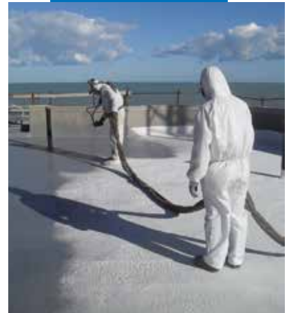
Purtop 400 M:n levitystä Triblock P -pohjusteen päälle
