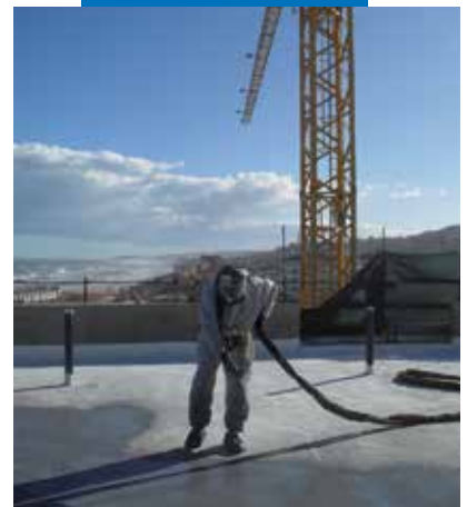
Purtop 400 M:n levitystä Triblock P -pohjusteen päälle
