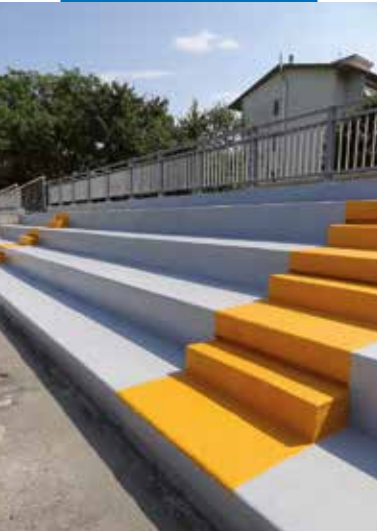
Terassikatso, vesieristeenä Purtop 400 M ja pinnoitteena Mapefloor Finish 55
