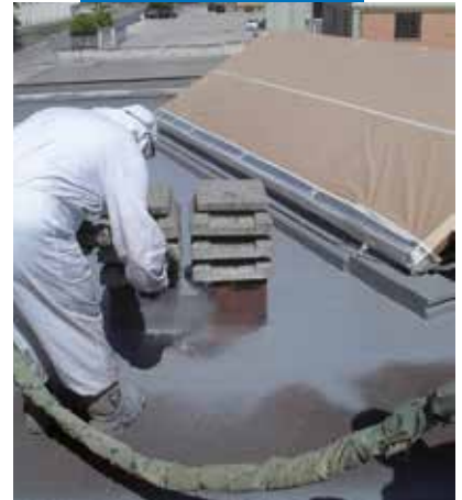
Purtop 400 M:n levitystä bitumikermille
